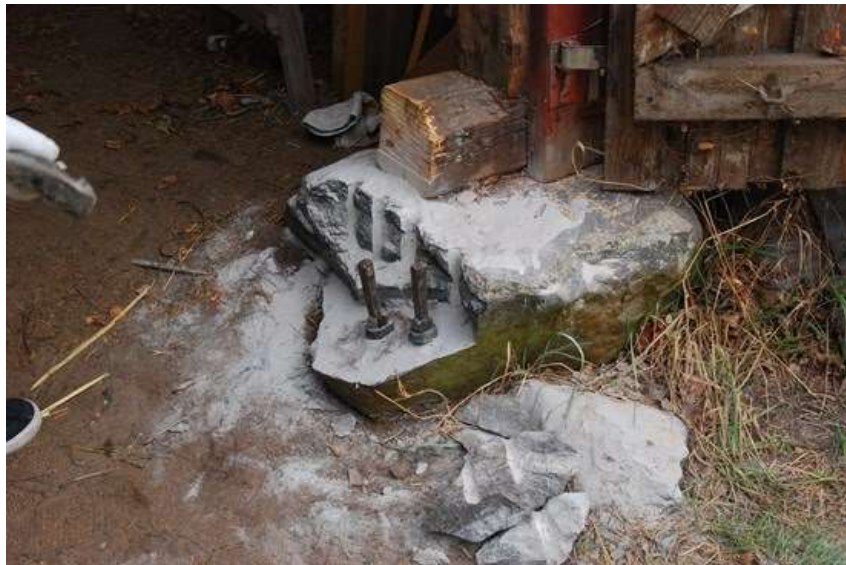
Ulf spräckte stenen som sticker ut i porten till ladan. Lite vassa kanter återstår att ta bort.
